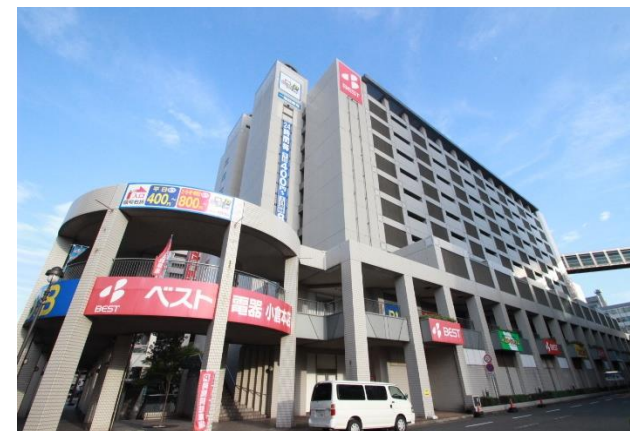
約1,000台の立体自走式駐車場
