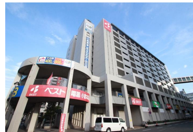
約1,000台の立体自走式駐車場
